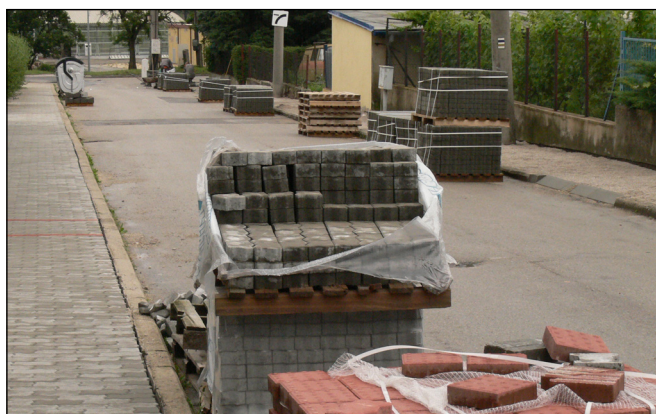
Jednou z prác v rámci Sociálneho podniku je aj rekonštrukcia chodníkov v dolnej časti mesta.
